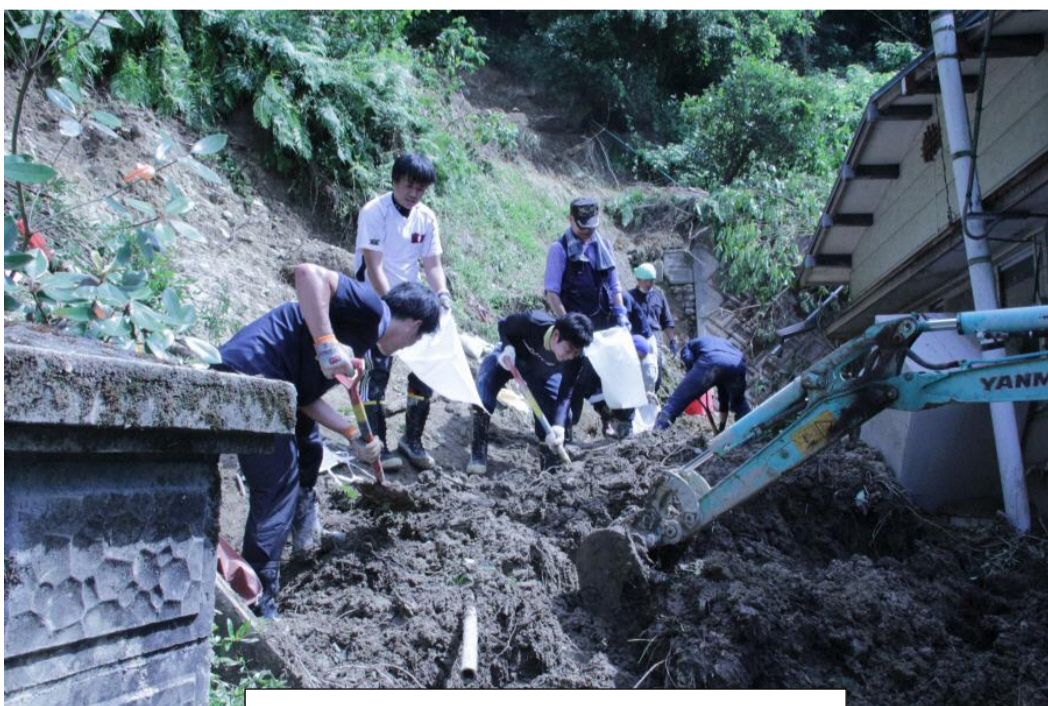
ボランティアが片島の土砂の除去作業
